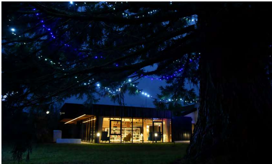
La nouvelle médiathèque de Vincey (Vosges) © DRAC Grand Est
