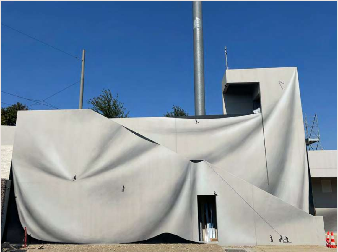
Vincent Broquaire, 1 % artistique, station de transport intermodale Paul Éluard à Strasbourg Vue d'ensemble de l'œuvre en cours de réalisation © Vincent Broquaire
