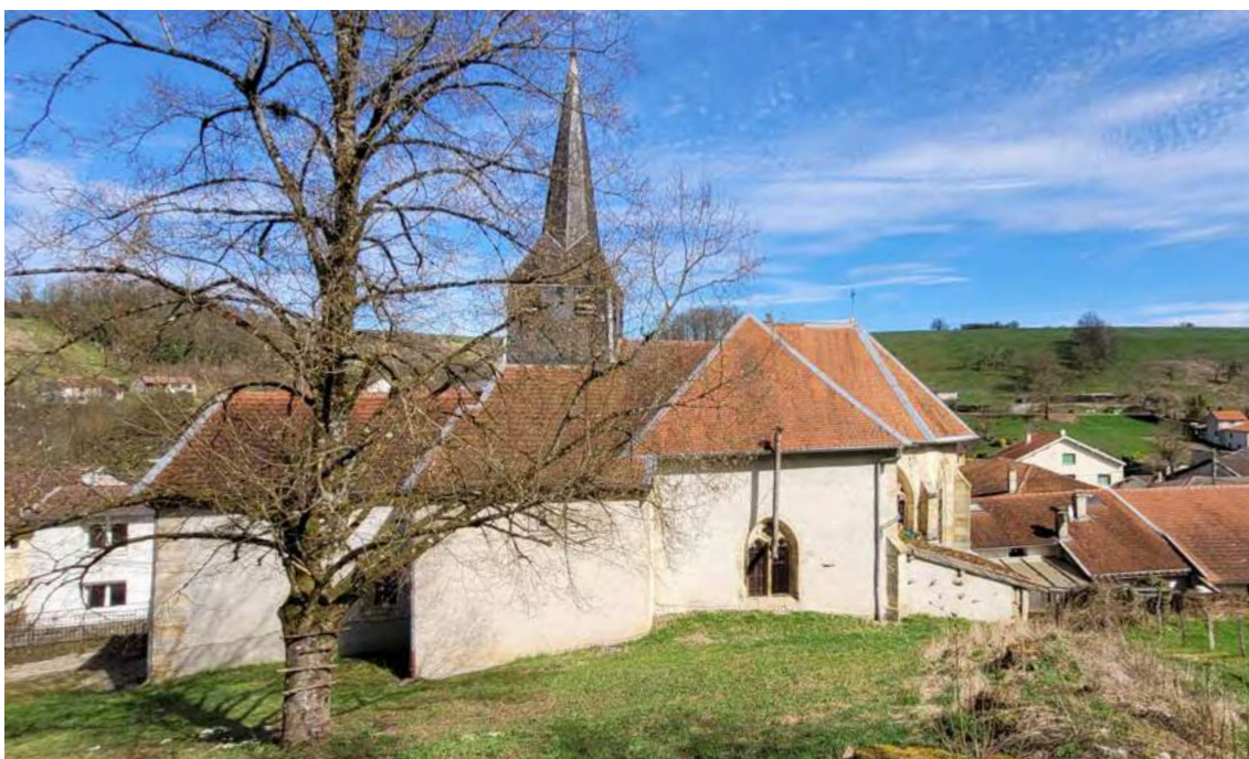
Église Saint-Pierre de Naives-Rosières (55), inscrite monument historique en 2024 : les travaux d'urgence et de mise en sécurité d'un montant de 663 010 € TTC (100 % État) seront menés sous la maîtrise d'ouvrage de la DRAC © DRAC Grand Est
