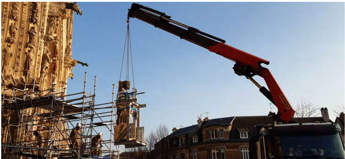
Cathédrale de Reims - Chantier test sur le portail central - Dépose de la statue du Roi David © DRAC Grand Est
